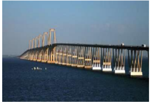
Lago Maracaibo, puente Rafael Urdaneta de 8 km de longitud.
